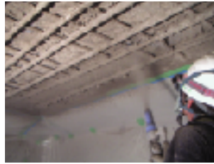
リフレGショットの吹き付け
