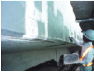
リフレモルセットの埋め戻し
