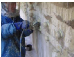
リフレフィルボンドの注入
