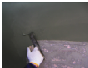
リフレベースパテの塗布
