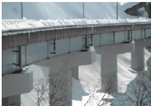
塩害・アル骨複合劣化抑止対策
