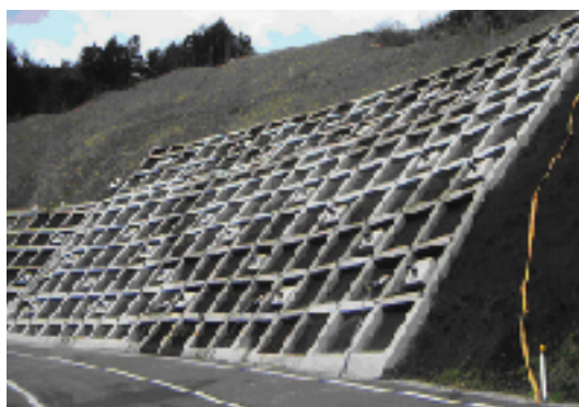
法枠ひび割れ補修
